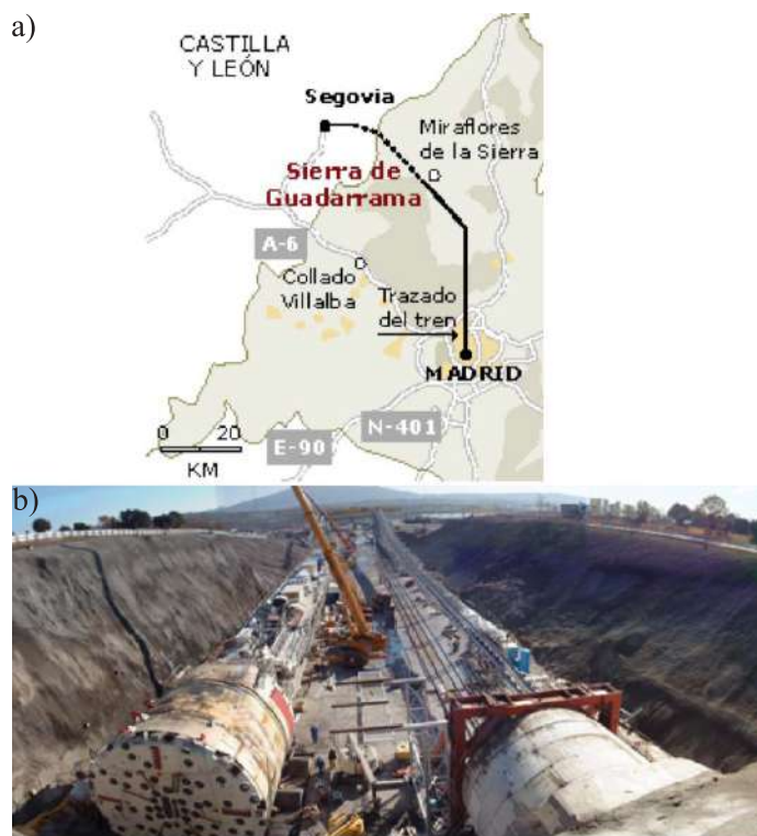
Figura 24: a) Ubicación de los túneles de Guadarrama, Comunidad de Madrid-Comunidad de Castilla y León, España y b) túneles en construcción-Bocas Sur (26 de noviembre 2002)
