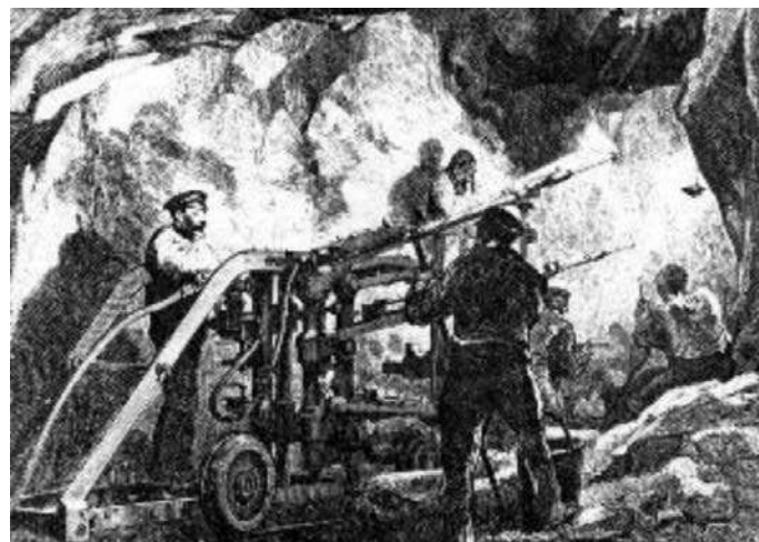
Figura 2: Construcción del túnel ferroviario de San Gotardo en los Alpes Suizos, trabajos de perforación en el frente de Airolo (Sandström, 1963)
