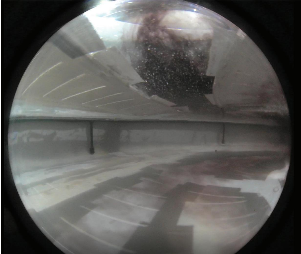
la vorticidad, succión de residuos por el tamiz y la autolimpieza del estanque completo. En la sección inferior que se forma, se concentran y eliminan rápidamente los residuos sólidos por un desagüe central.
